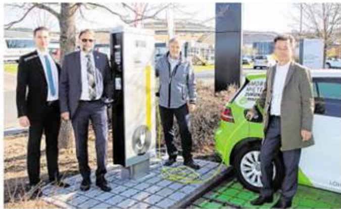
Es gibt in Karlstadt eine neue Ladesäule für Elektroautos auf dem Gelände des Autohauses Grampp. Im Bild von links: Michael Wagner, Jochem Maier, Stefan Schnagl von der Energieversorgung Lohr-Karlstadt und Peter Grampp.
